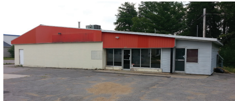
Nouveau bâtiment pour l'église de Trois-Rivières
