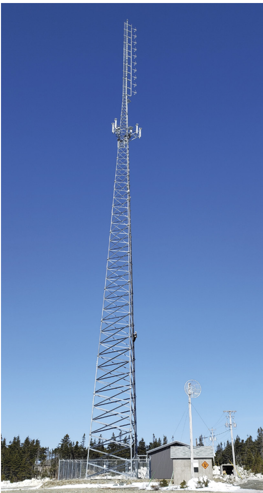
La nouvelle tour FM Lighthouse
